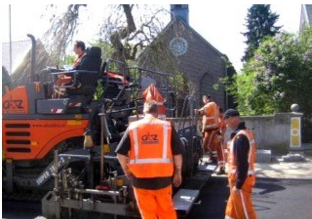
H. Kruisstraat, de eerste asfaltlaag, 14 april 2014
